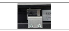
3. 门处于闭合位置, 检查确定门刀是闭合的(层门门锁开着)
